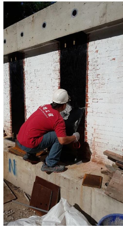
貼覆CFRP
