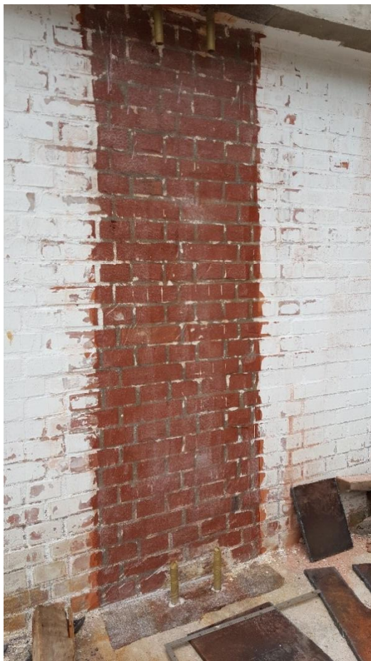
牆體表面處理
