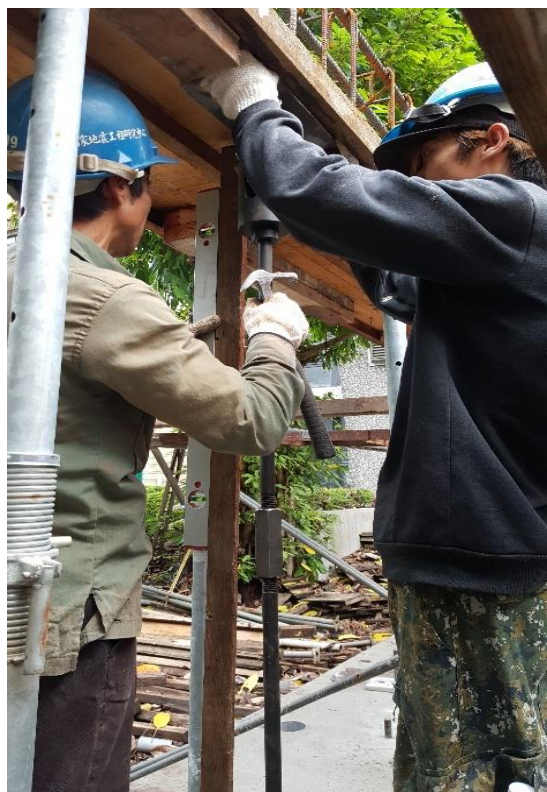
水平尺定拉力鋼棒之垂直
