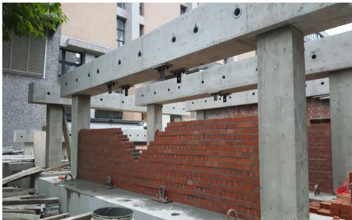
後砌式磚牆砌築
