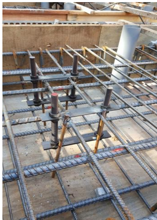
預埋錨栓固定
